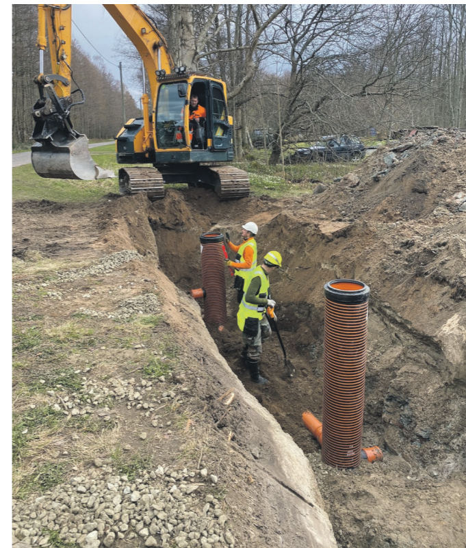
Vee- ja kanalisatsioonitrassi pikendamine Tööstuse kinnistul.
